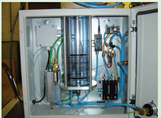
2 bombas para lubricación interior
