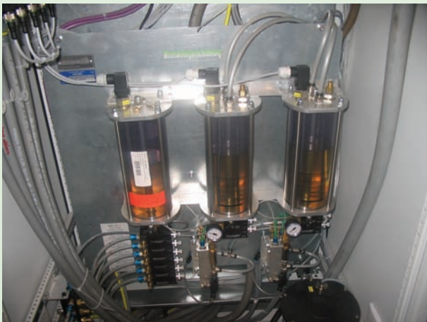
6 bombas para lubricación exterior 4 bombas para lubricación interior
